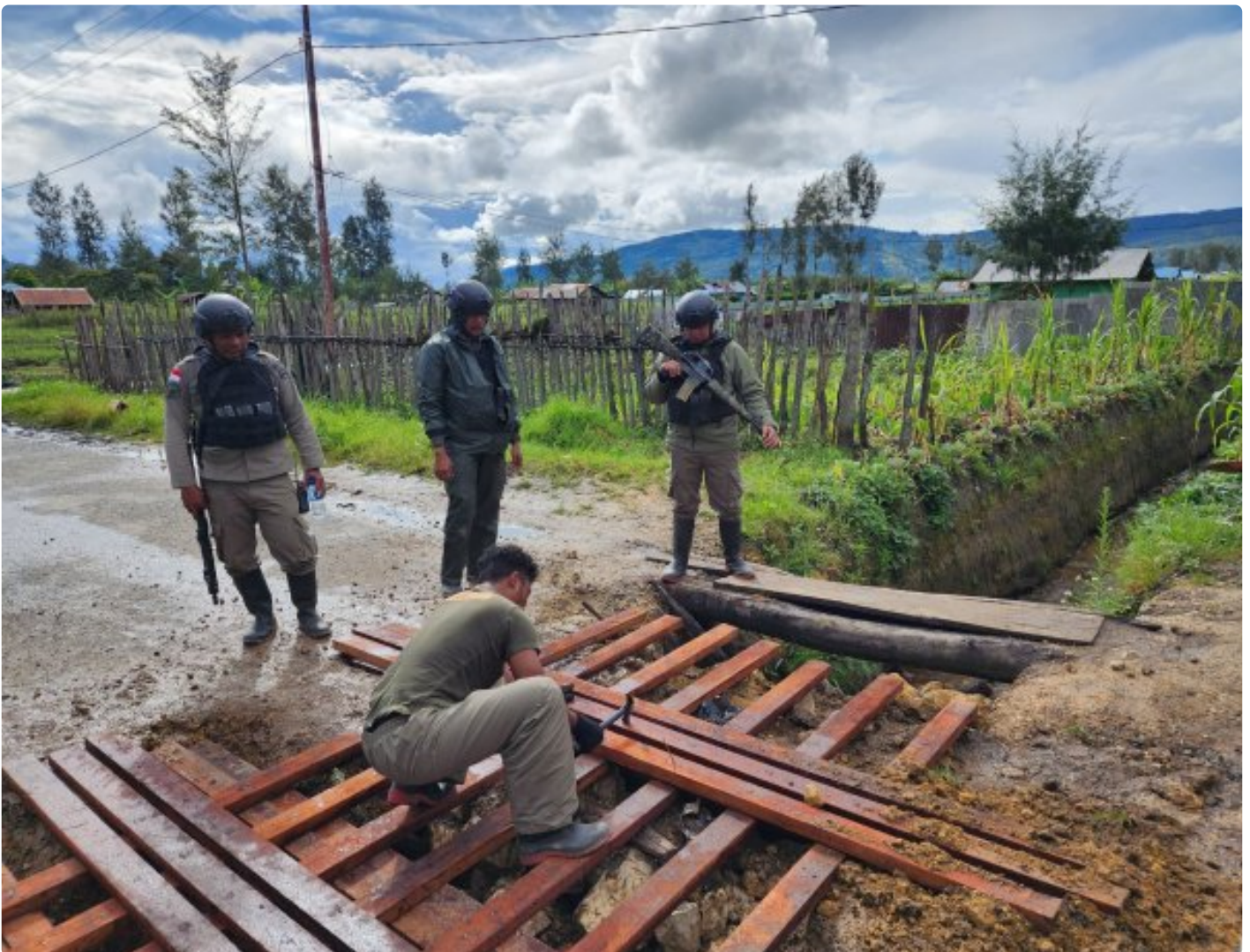
PANIAI - Satgas Bantuan Ops Damai Cartenz-2024, membuat jembatan sementara untuk menghubungkan jalan dari ibu kota paniai ke distrik bibida
